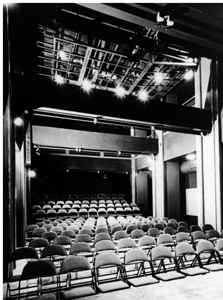
Rekonstrukce divadla Archa architektem M. Melenou – prohlídka byla součástí setkání se členy diplomatického sboru
